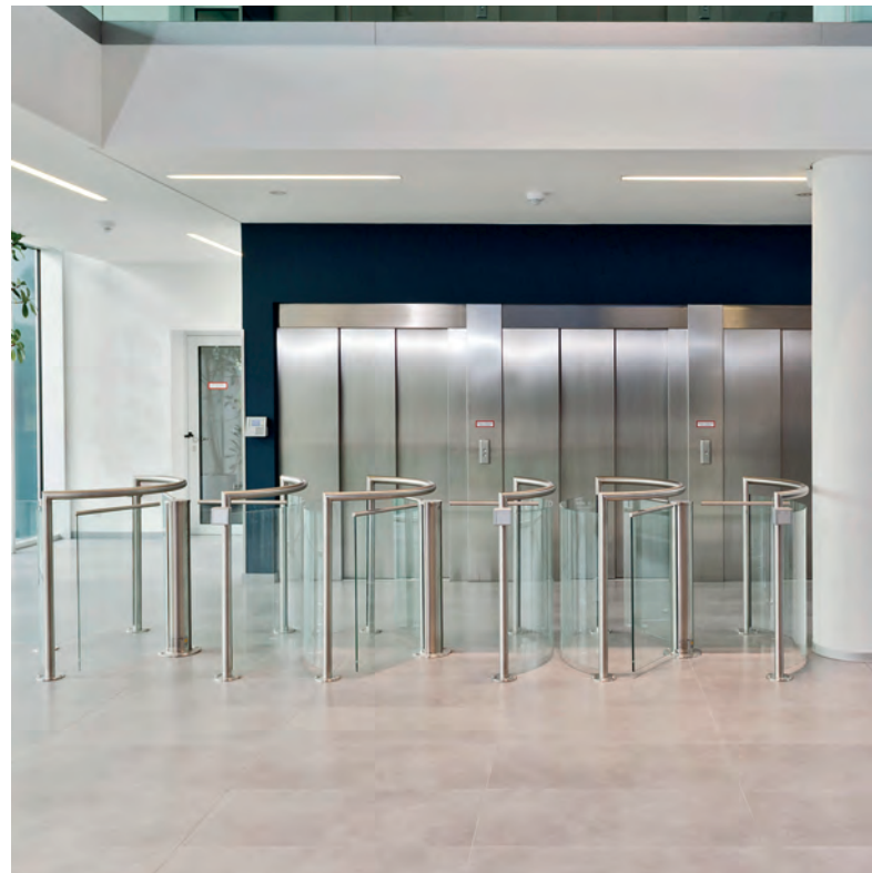
Absicherung vor dem Aufzug
