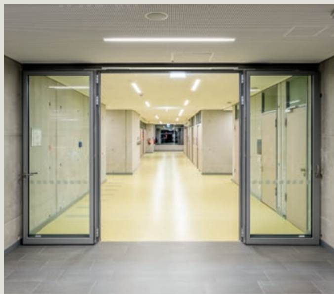
TS 98 XEA GSR EMR (wbudowany czujnik dymu) z zewnętrznymi chwytakami elektromagnetycznymi EM 500
