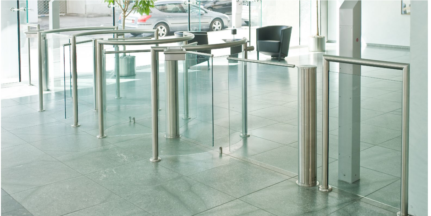
01 Mehrfachanlage im Foyer – in Sichtweite vom Empfangspersonal
