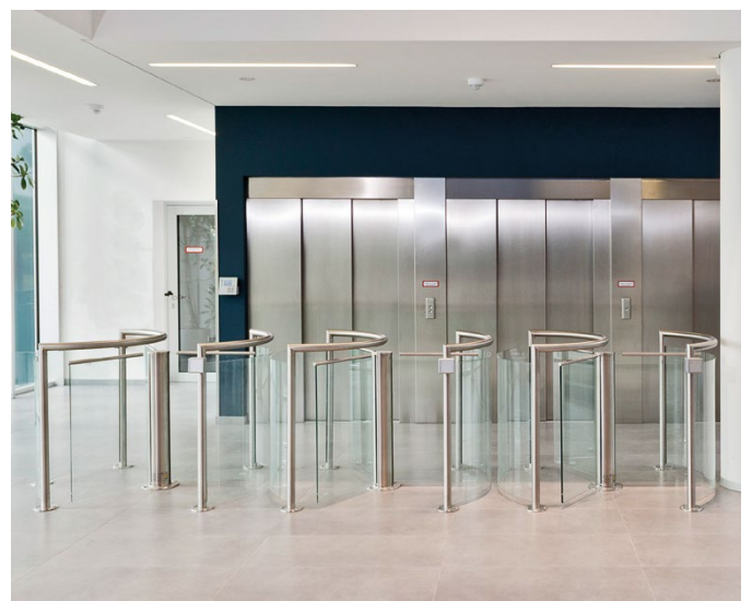
03 Absicherung vor dem Aufzug
