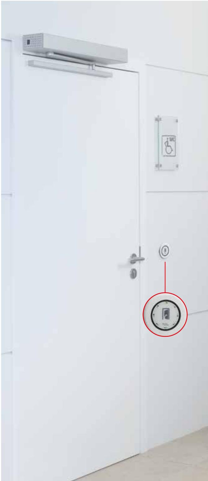
Le grand avantage d'une porte automatique est lié à la création d'accès sans obstacle dans les bâtiments. L'ouverture automatique de la porte doit fréquemment être commandée volontairement par des personnes à l'aide de boutons. Pour cela, on utilise différents modèles de boutons à pression simples ou de boutons à grande surface. L'inconvénient de ces boutons est qu'on ne les identifie pas toujours comme des générateurs d'impulsion pour l'ouverture d'une porte.
